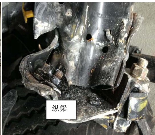
图 13 纵梁前端变形严重
