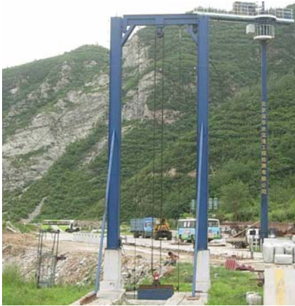
图 2 重锤及起重塔
